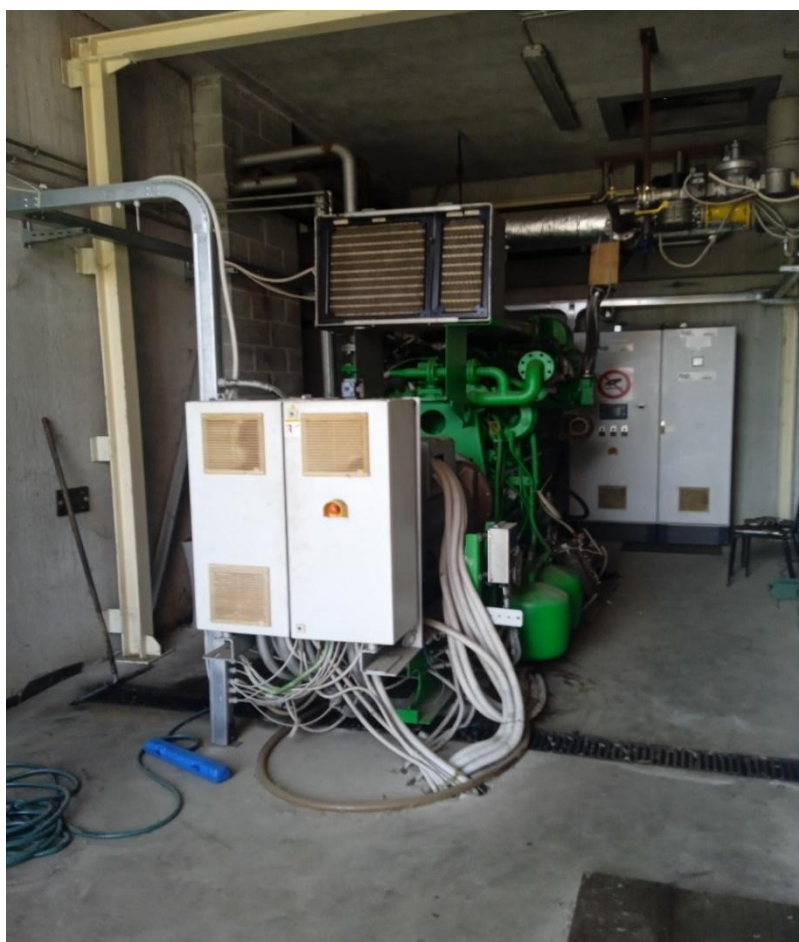
15) Sala motore con la sua presa d'aria insonorizzata
