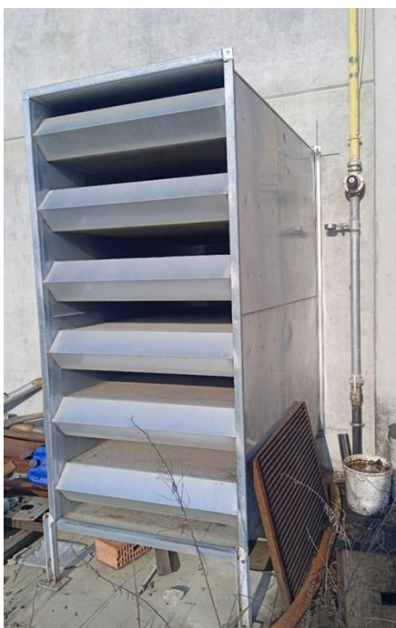
15) Sala motore con la sua presa d'aria insonorizzata
